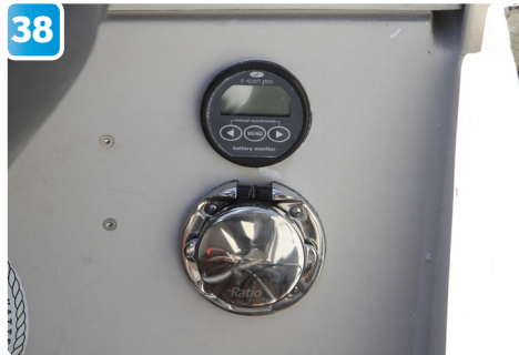
38 Batterimätaren och landströmsintag placeras i framkanten av sittbrunnen.
