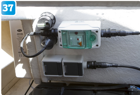
37 Jordfelsbrytaren får en bra plats strax ovanför batteribanken.
