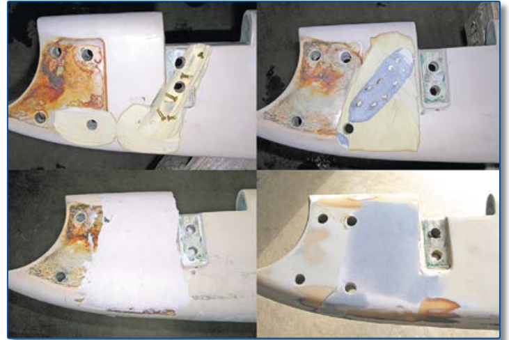
Bilder från roderreparationen.
