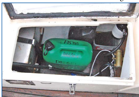
Tank, filter och pump.
