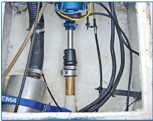
Ljuddämpare, reglagevajrar samt slangen till skvallerstrålen.
