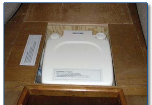
En enklare installation av en enklare toalett. Porta Potti 335 med 10 liters hålltank.
