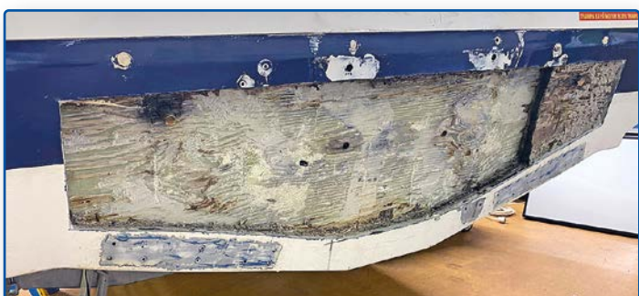
Här har det mesta av den sura plywooden tagits bort. Återstår nu att fräsa bort den plywood som finns en bit in runt hålets kanter.
