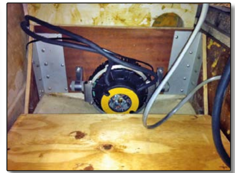
I en MS-20 placeras motorn ungefär där backslaget förr satt.
