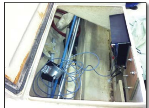
Installation på gång.
